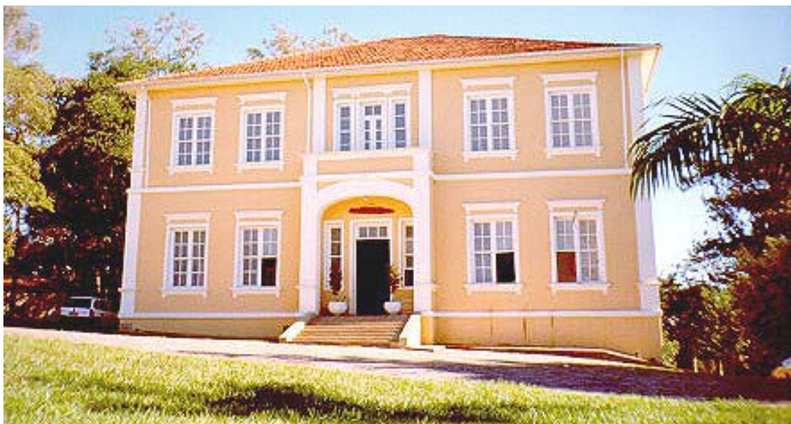
FIGURA 19: Edifício Álvaro Botelho, o primeiro da EAL, inaugurado em 1921 Fonte: Foto extraída do site http://www.land.ufrj.br/~allyson/lavras/bimoreira.htm
