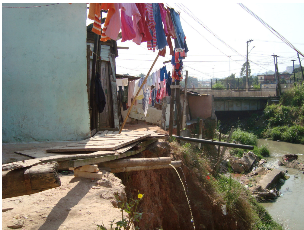
Fotografia 1 – Sistema de esgotamento enterrado e individualizado.
