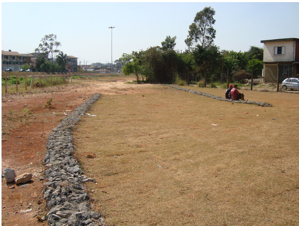
Fotografia 11 – Situação atual das obras, entrada pela rua Castelo do Piauí em agosto de 2010.
