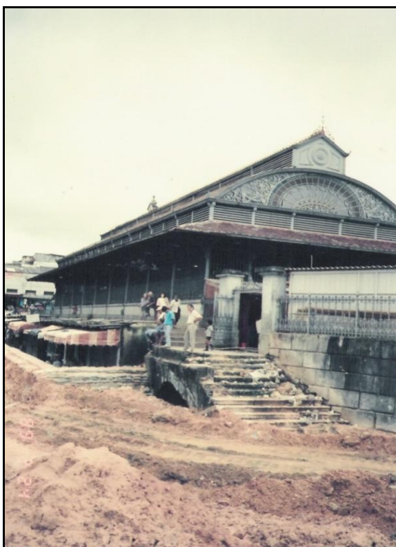
Fotografia 18 Lateral do Mercado Adolpho Lisboa 162 . Fonte: Amazonas (1987b).
