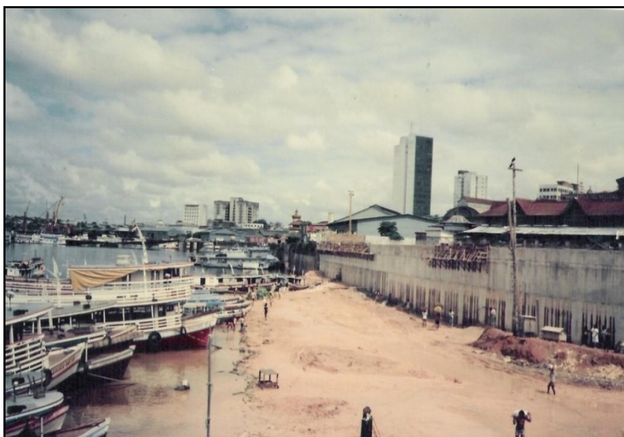
Fotografia 17 Construção do muro de arrimo em frente ao Mercado Municipal Adolpho Lisboa. Fonte: Amazonas (1987b).
