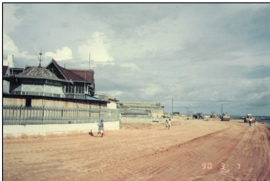
Fotografia 21 Construção da Avenida Beira Rio (Manaus Moderna). Fonte: Manaus (1987b).
