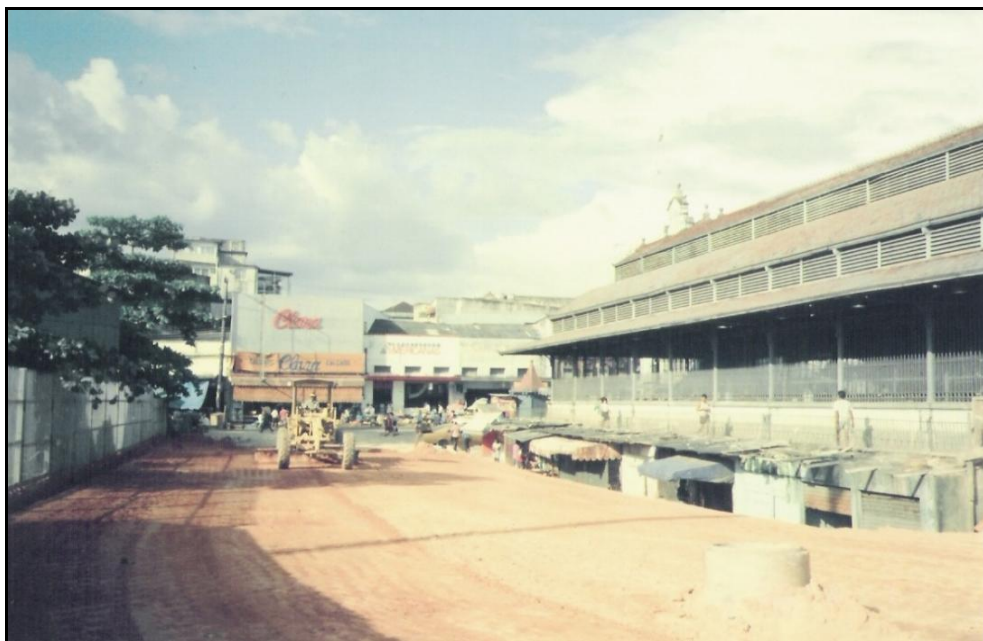
Fotografia 19 Início da Avenida Beira Rio (Manaus Moderna). Fonte: Amazonas (1987b).
