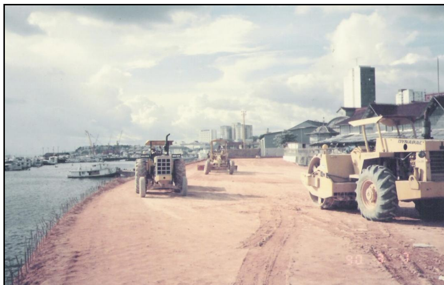
Fotografia 22 Construção da Avenida Beira Rio (Manaus Moderna). Fonte: Manaus (1987b).
