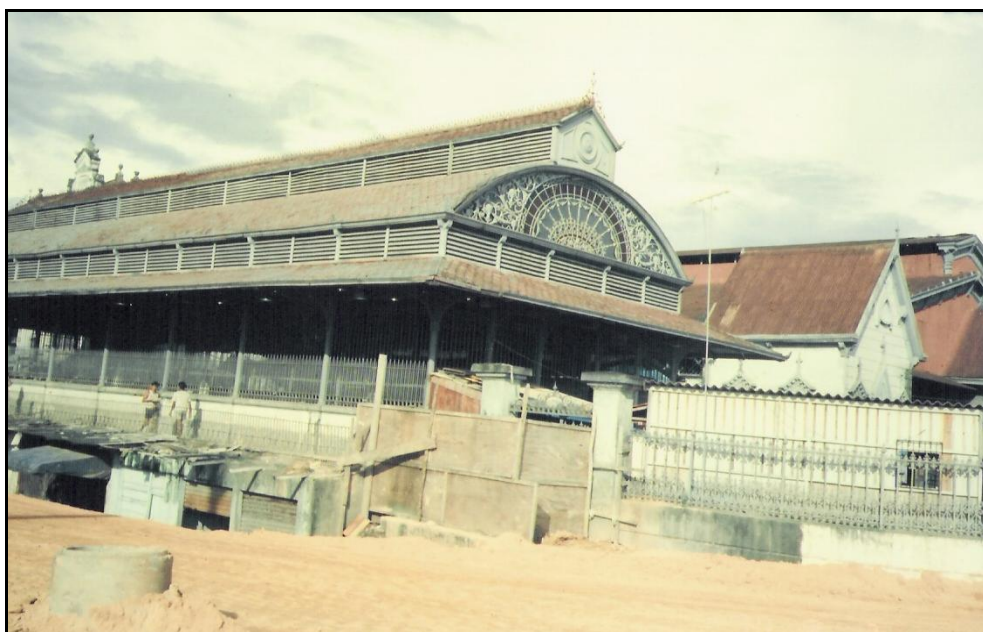
Fotografia 20 Lateral do Mercado Adolpho Lisboa. Fonte: Amazonas (1987b).
