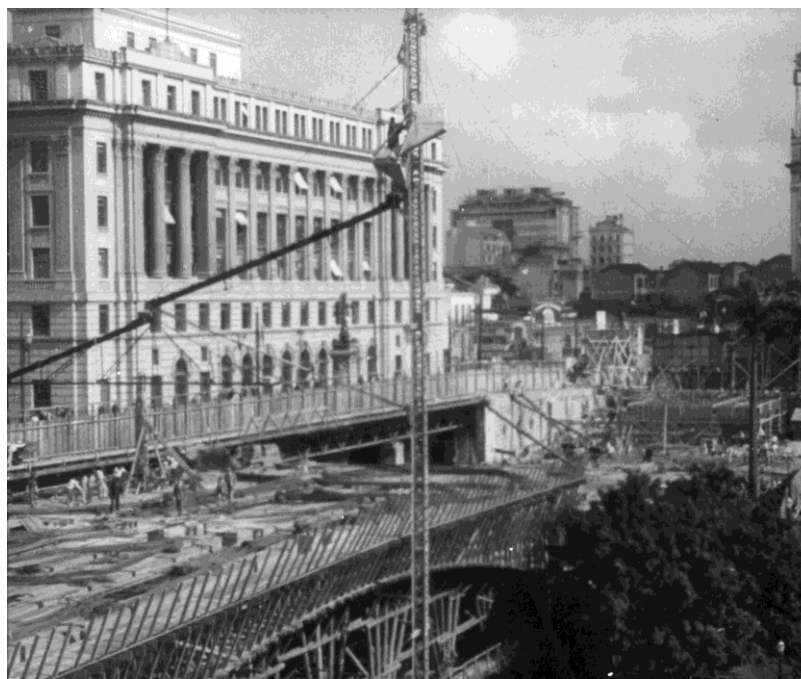
Reconstrução do viaduto do Chá.
