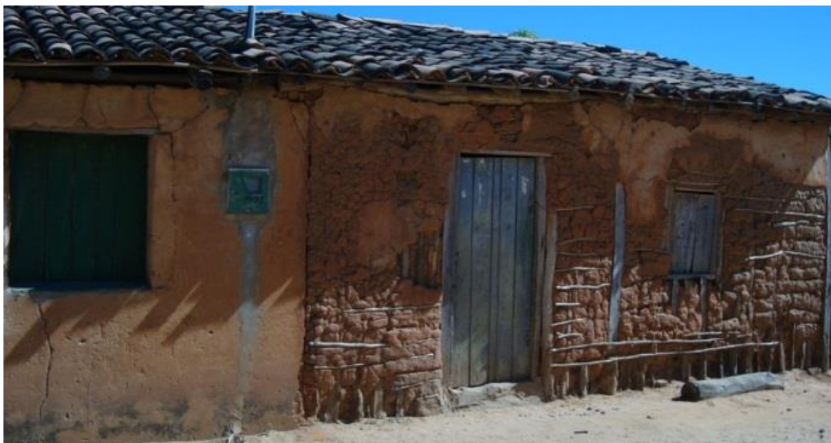
Foto 7 - Casa antiga construída de enchimento, 2012
