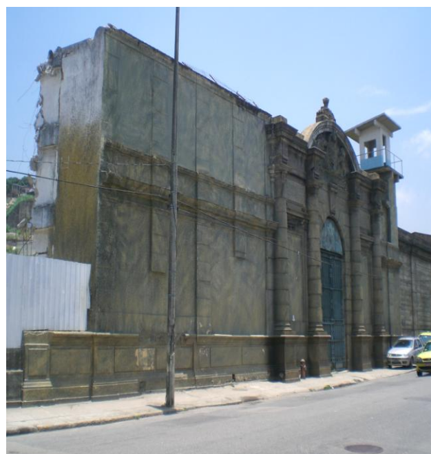
Figura 8 - Escombros da Casa de Correção 177
