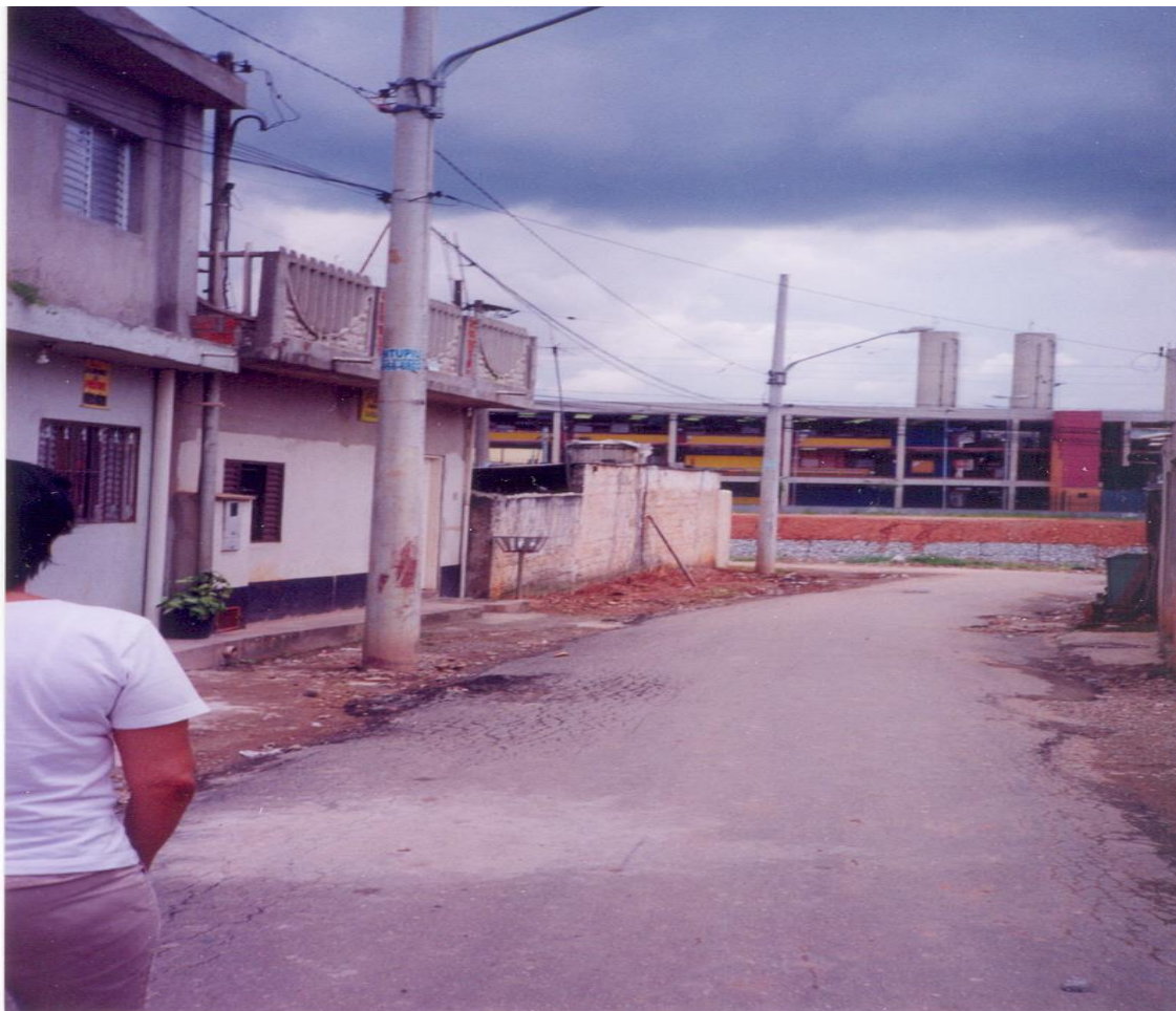
Rua Claudio da Costa, ao fundo CEU Jambeiro
