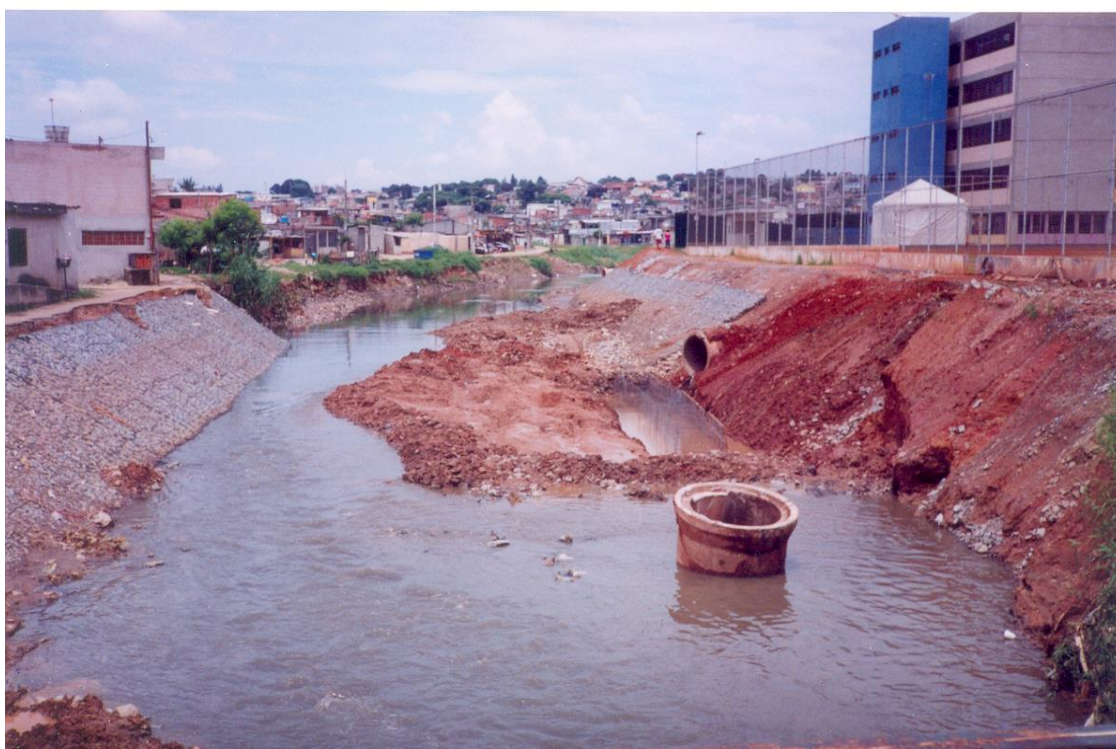
Vista a partir da ponte sobre o córrego; à época, em obras para se evitar assoreamento. Nota-se o poder público se fazendo presente, com obras de infraestrutura no bairro
