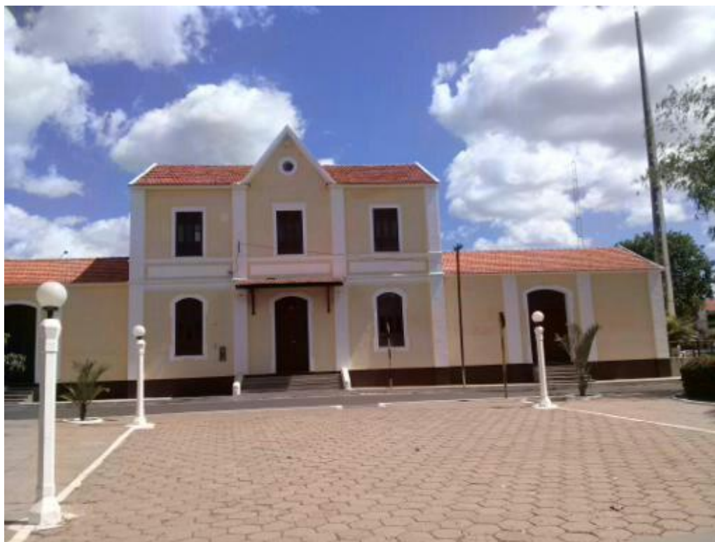
Estação Ferroviária de Codó (Restaurada) – junho de 2014 Fotos do Autor
