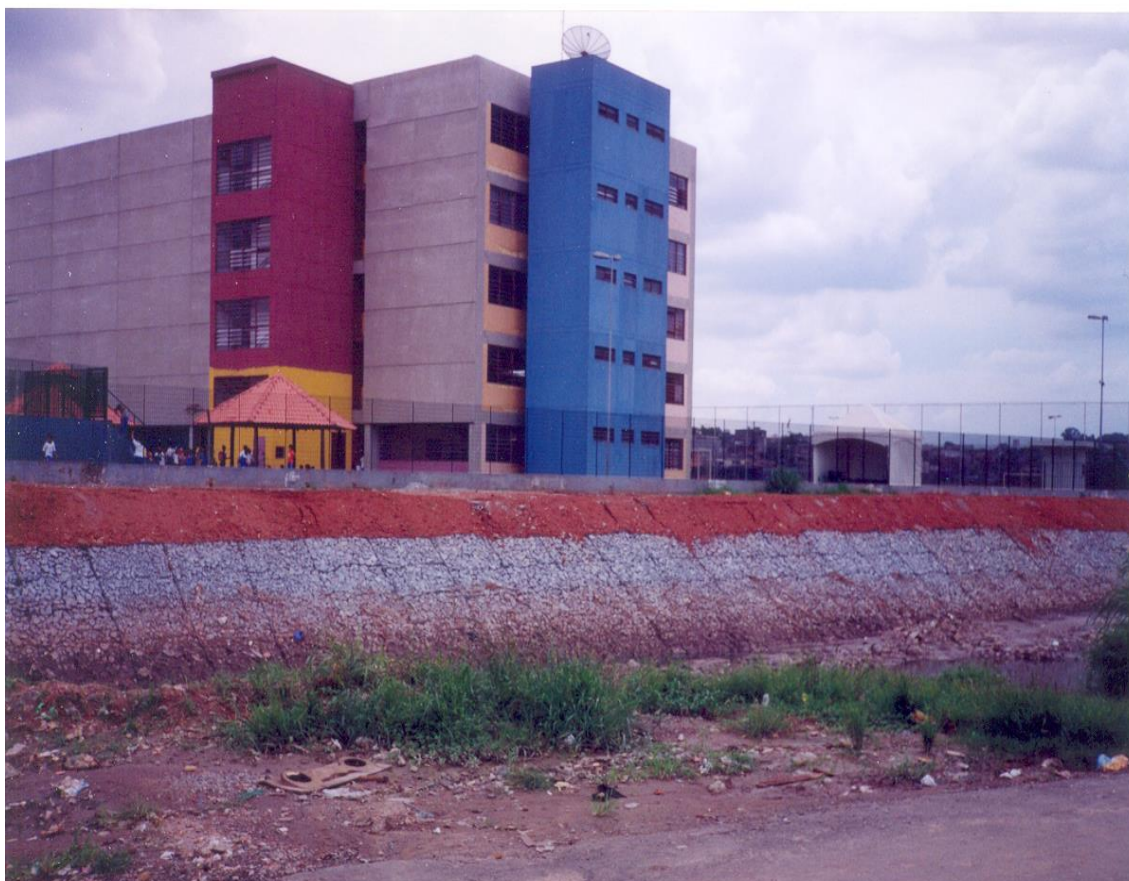
Vista do Bloco Administrativo e Cultural do CEU, a partir da Av. Sansão Castelo Branco, Jardim Aurora.
