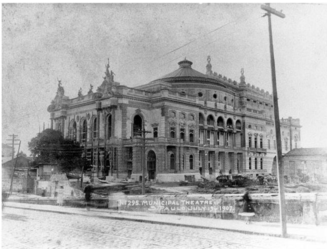
“Theatro Municipal” no período de obras, em 1907 141 .
