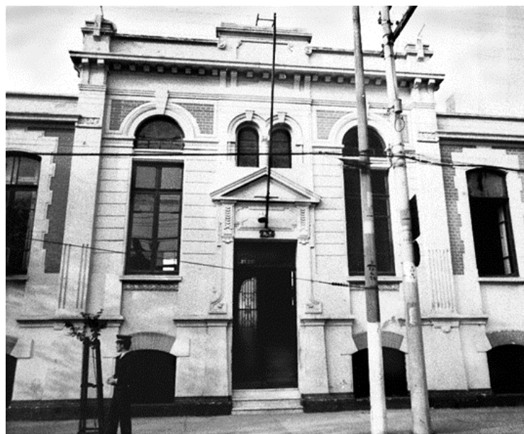
Figura 3 – Fachada da Rua Marcondes Salgado Filho
