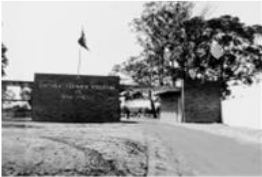
Figura 6 – Fachada da entrada – Canindé
