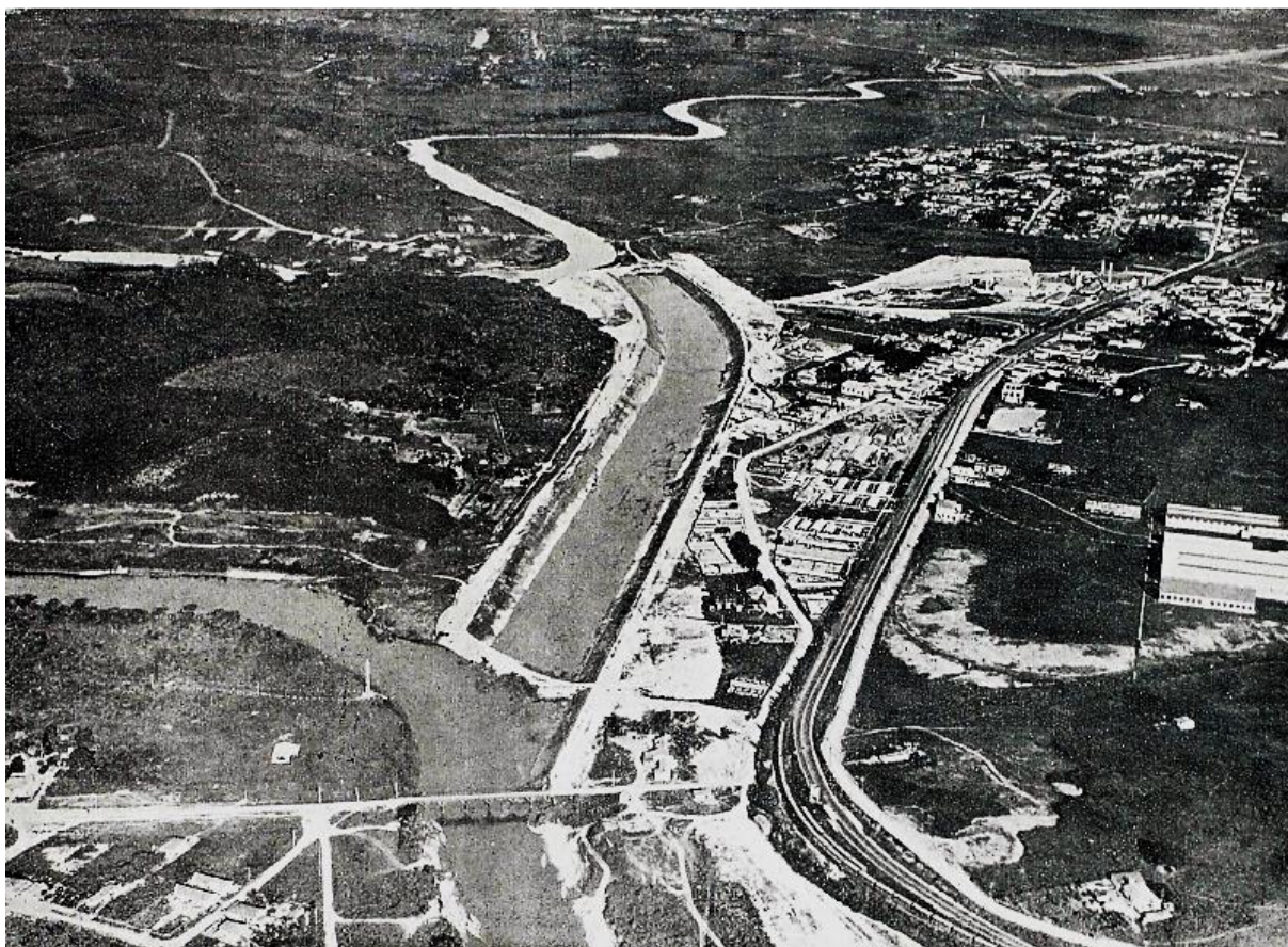
Fig. 42 – Trecho de Osasco – Canalização ocorrida em 1938. Maia, 1945.
