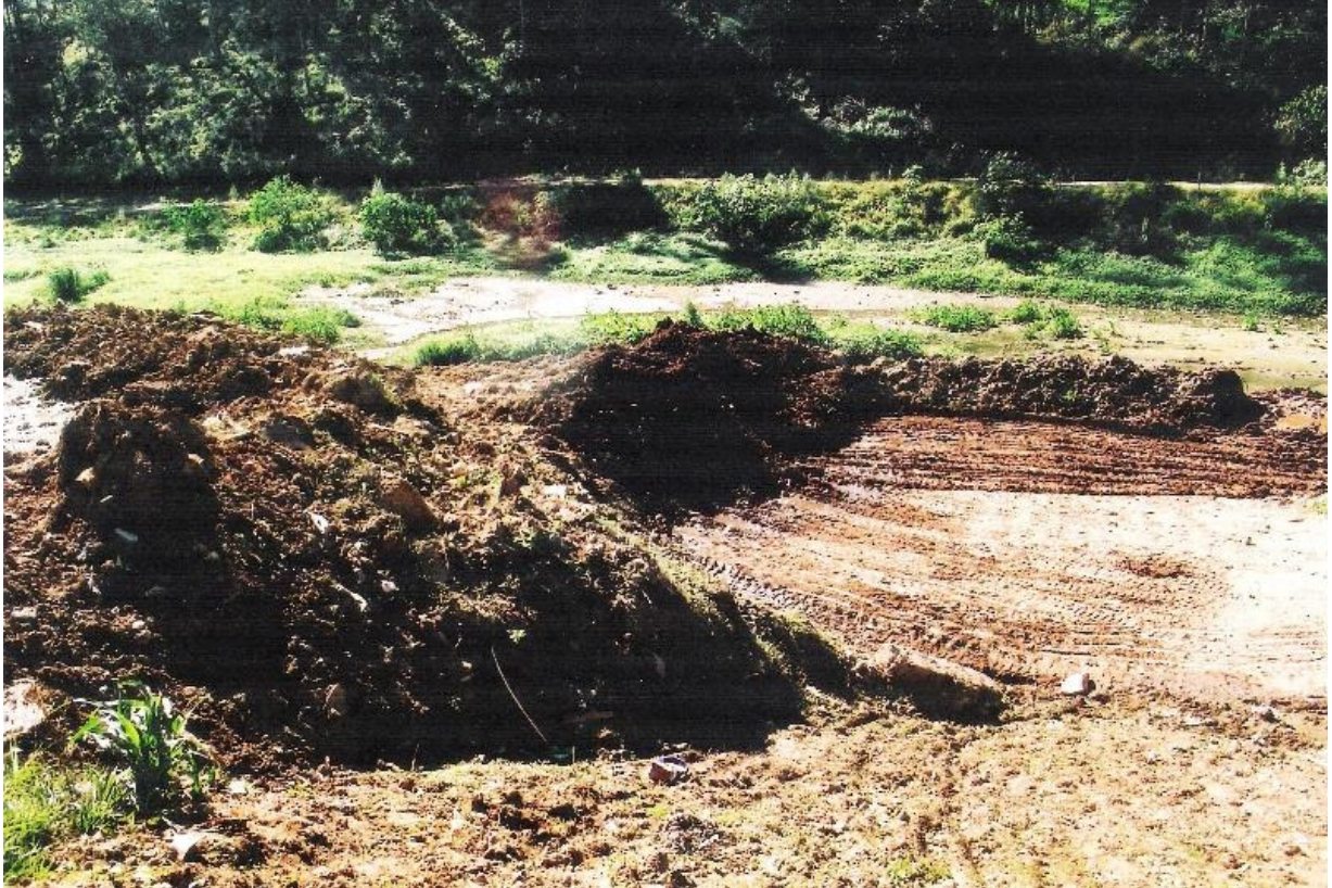
Fig. 96 – Material acumulado no piscinão Bananal à espera da retirada (2012).
