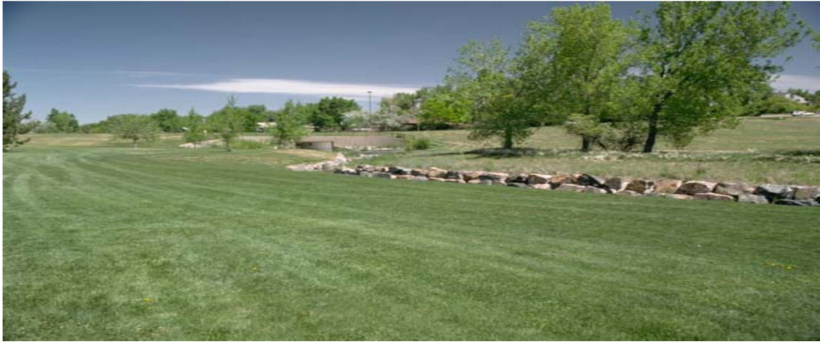
Fig. 61a - (Bible Park) Bacia de detenção com múltiplas funções inteiramente integradas ao espaço. Urban Drainage and Flood Control District, 2001.
