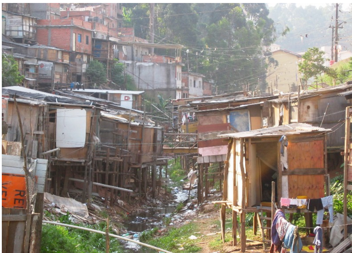
Fig. 97 – Esgoto lançado diretamente no Córrego. Jardim Damasceno. EPUSP, 2004.
