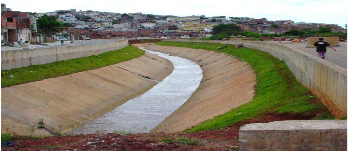
Fig. 88 – Córrego Guaraú: canalização a céu aberto. EPUSP, 2005.
