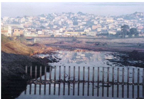
Fig. 94a - Entrada do Córrego Guarau com paliteiros para controle de resíduos sólidos.
