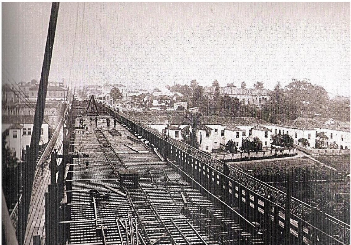
Fig. 34 – Reforma do Viaduto do Chá para passagem dos bondes elétricos (1902).
