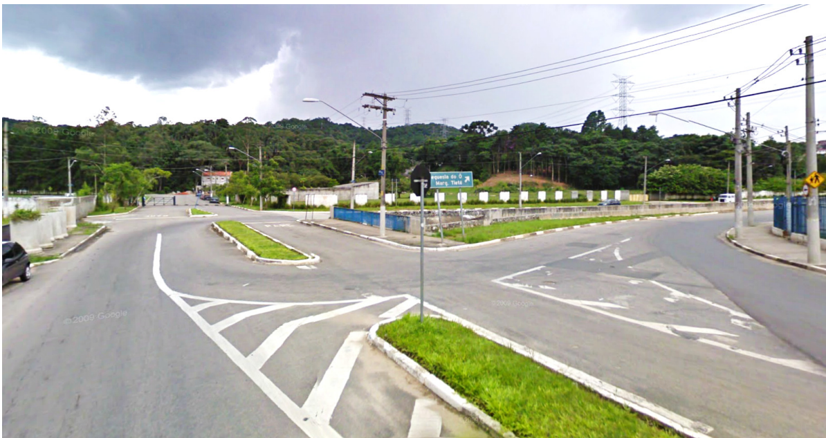
Fig. 87 – Canalização Córrego Cabuçu de Baixo – Nota-se a esquerda que a retificação termina em frente à entrada do condomínio residencial. Google Earth, 2011.
