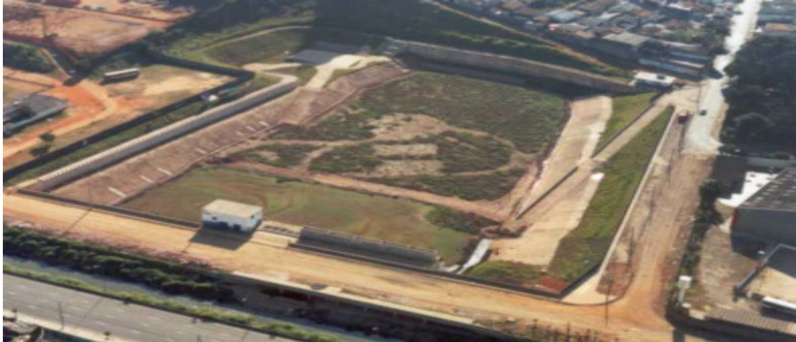
Fig. 63 - Reservatório fora de linha (Piscinão TC2 – Casa Grande, Diadema). Acervo DAEE.
