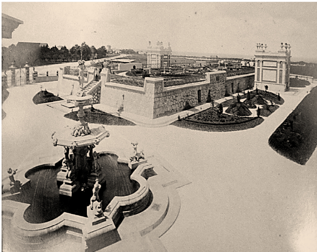
Fig. 35 – Reservatório da Liberdade ou Avenida (1894). Vilar, 2007.
