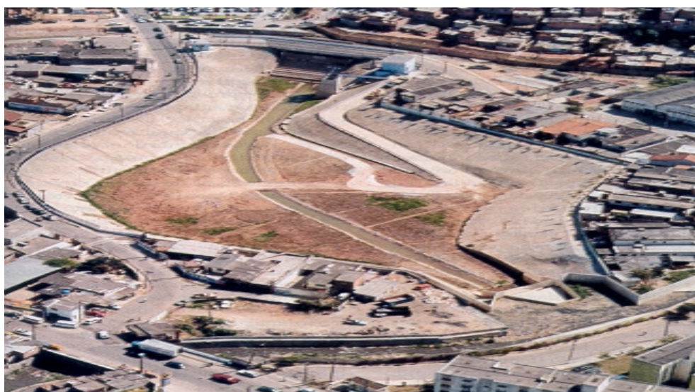
Figura 62 – Reservatório em linha (TPI- 2 / Jardim Nova República Embu das Artes / Córrego Pirajuçara). Yazaki, 2005.
