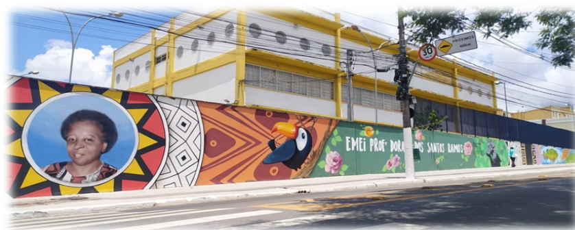
Figura 3 - Pintura do muro lateral externo da EMEI, em homenagem a ProfªDoraci
