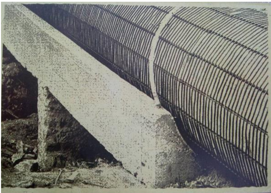
FIGURA 11 – Fotografia do Aqueduto de cimento armado – Cartão Postal Comemorativo dos 90 Anos da Estação de Tratamento do Alto Cotia – ACERVO MEMORIAL SABESP
