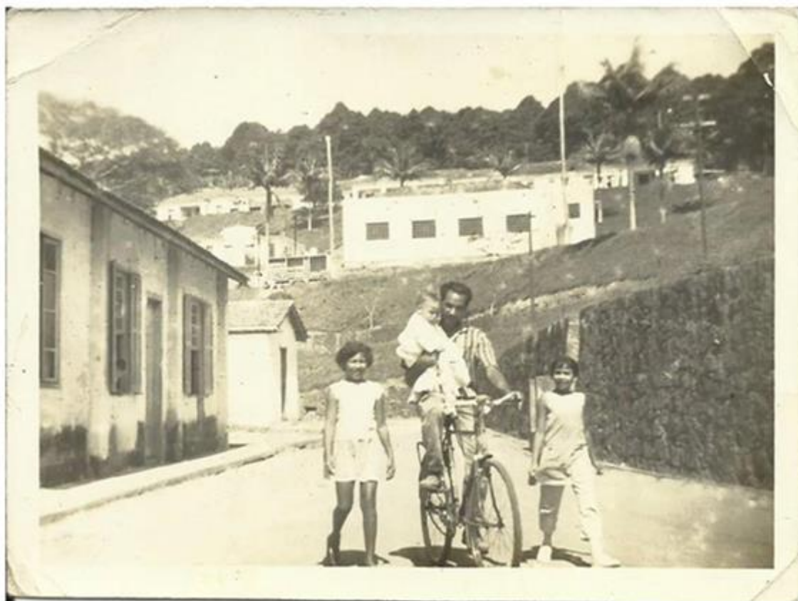
FIGURA 49 - Fotografia das casas dos conserveiros (na lateral) sem a antiga casa de madeira. No centro da Sede e ao fundo o conjunto de casas dos operadores de filtros e administradores.
