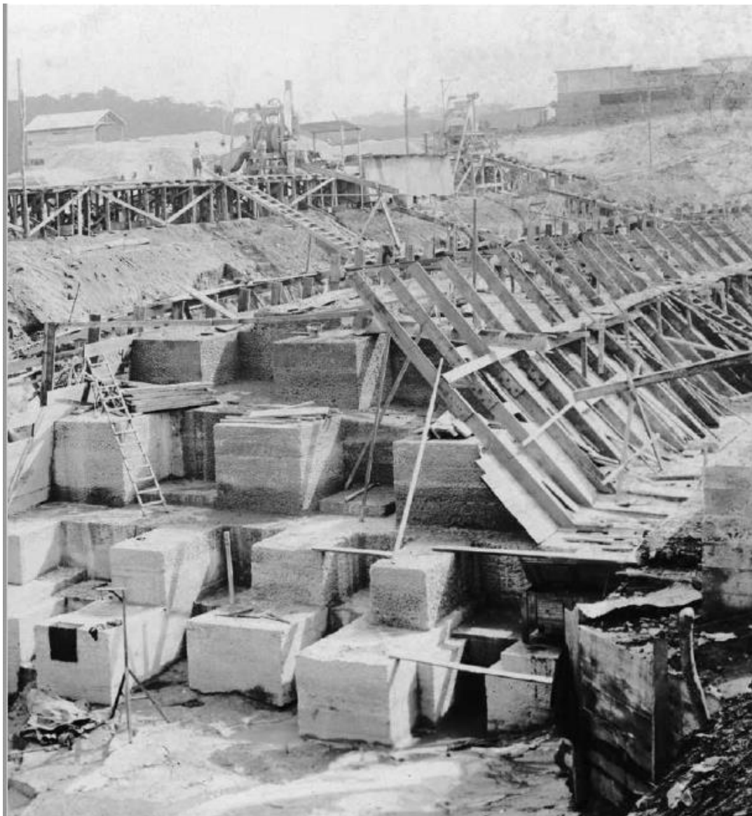
FIGURA 15 - Construção da barragem Pedro Beicht - sistema de abastecimento de água do Alto Cotia. Fotografia produzida em 11/6/1929. Acervo Memória Sabesp
