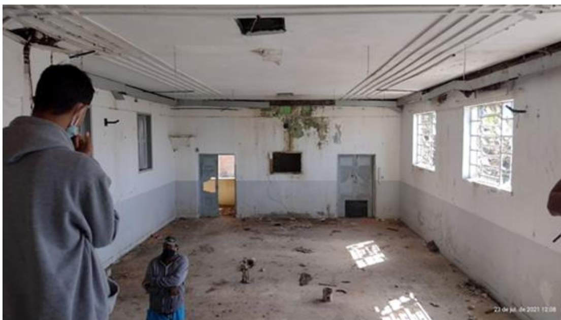
FIGURA 53b - Fotografia do Salão interno da Sede
