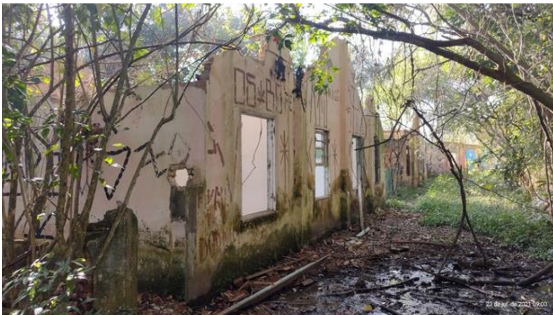
FIGURA 50 -Ruínas das antigas casas dos Operários – fotografia realizada pela pesquisadora 23/07/2021
