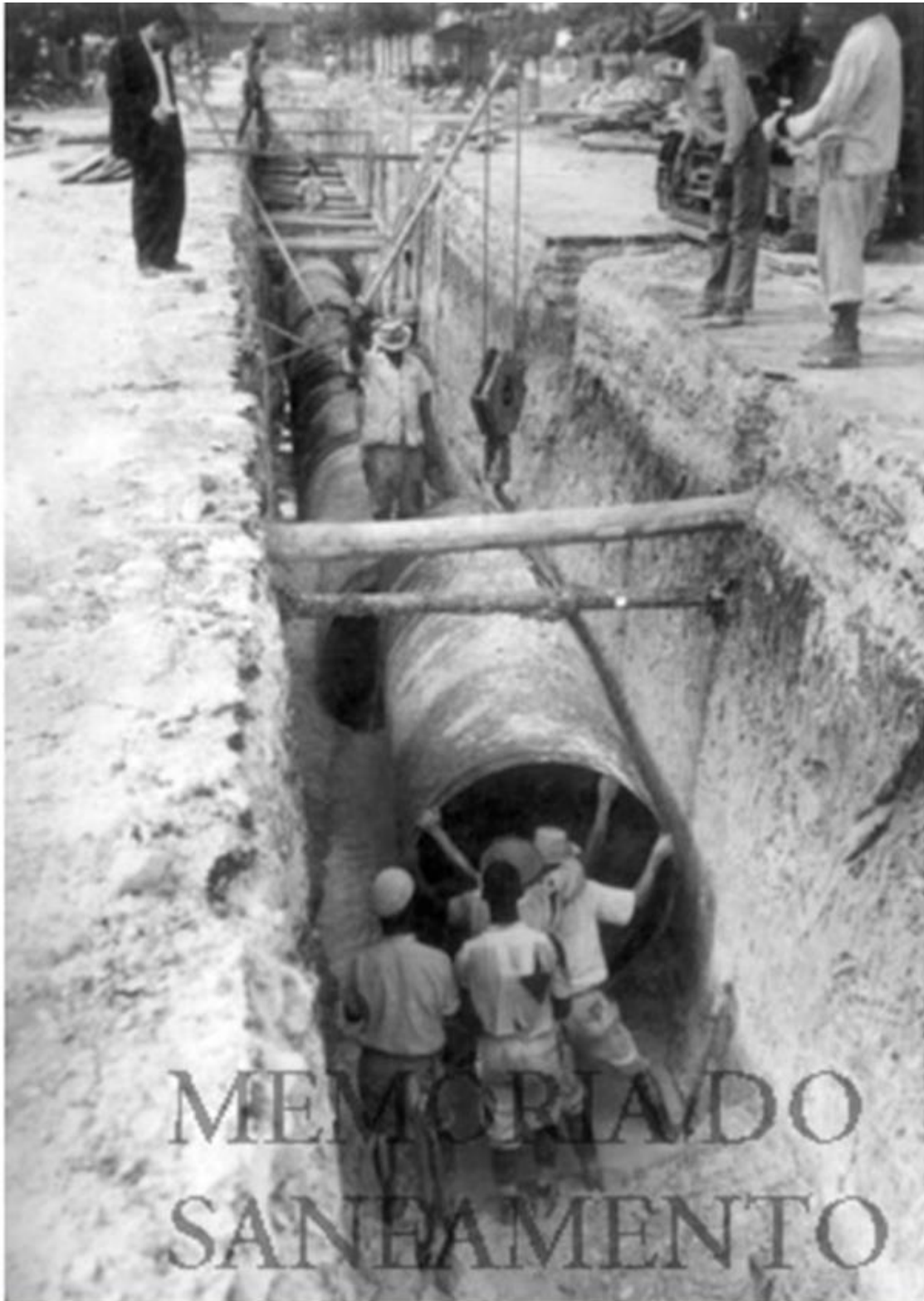
FIGURA 10 – Fotografia dos trabalhadores nas obras de assentamento, do trecho localizado na Avenida Brasil, da 2ª linha do Cotia – Adutora por gravidade, pertencente ao Sistema Alto Cotia. Local: São Paulo – SP. Disponível: http://memoriasabesp.sabesp.com.br/acervos/acervos.asp
