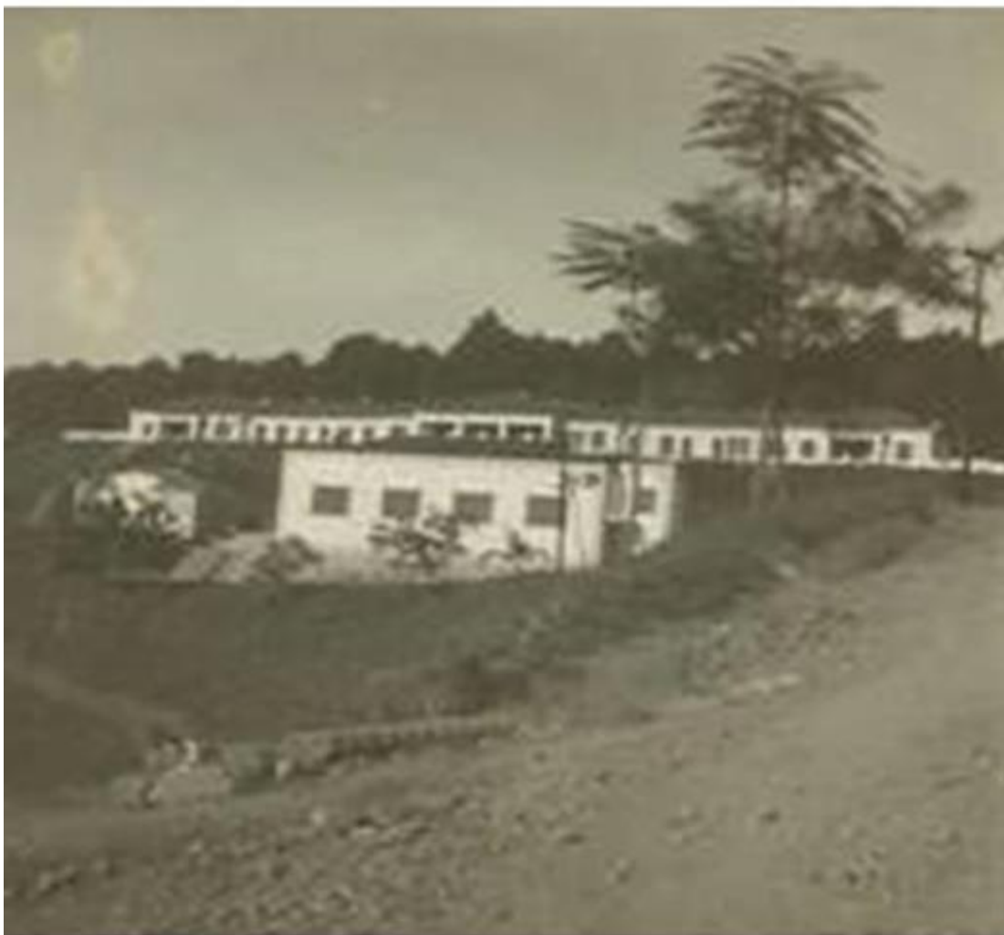
FIGURA 46 - Parte Alta (lado esquerdo) Conjunto de Casas acima da “Sede” – Associação dos Trabalhadores, (edificação do Centro da Foto), casas dos administradores, encarregados supervisores, fiscais.
