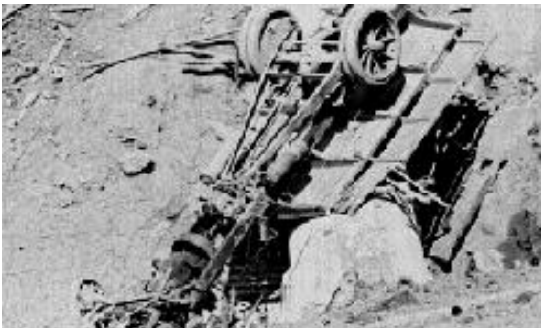
FIGURA 14 – Fotografia de uma das carroças tombada durante a construção da Represa Pedro Beicht no Morro Grande – Acervo Memorial SABESP
