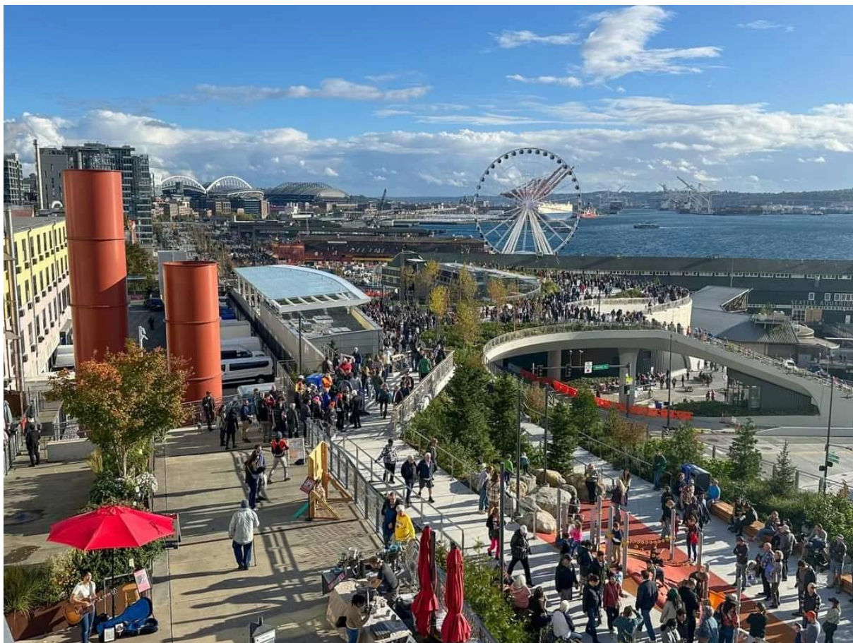
Figura 88: Depois da remoção do Viaduto Alaskan Way .
