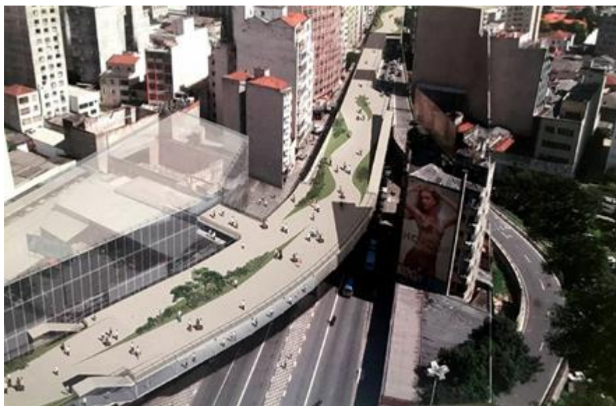
Figura 78: Vista de cima do parque e do túnel.
