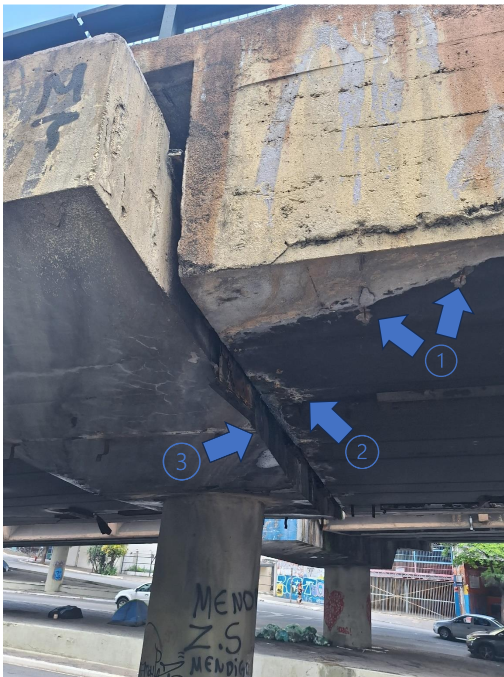
Figura 69: Mesoestrutura do Trecho 1.
