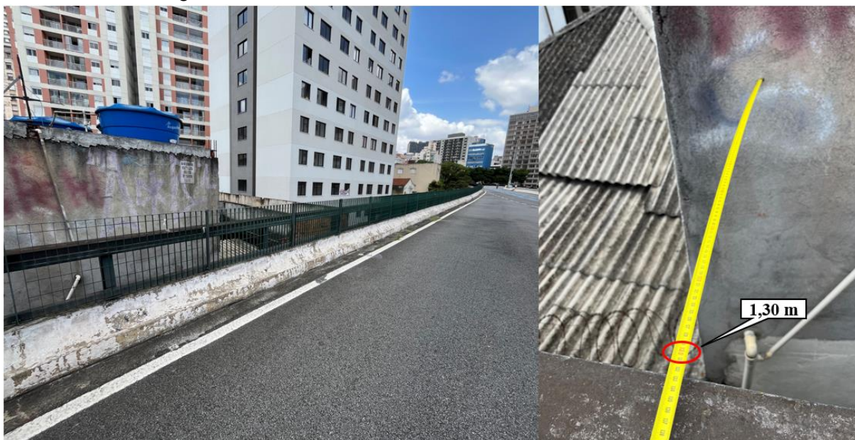
Figura 65: Proximidade das moradias lindeiras do elevado.
