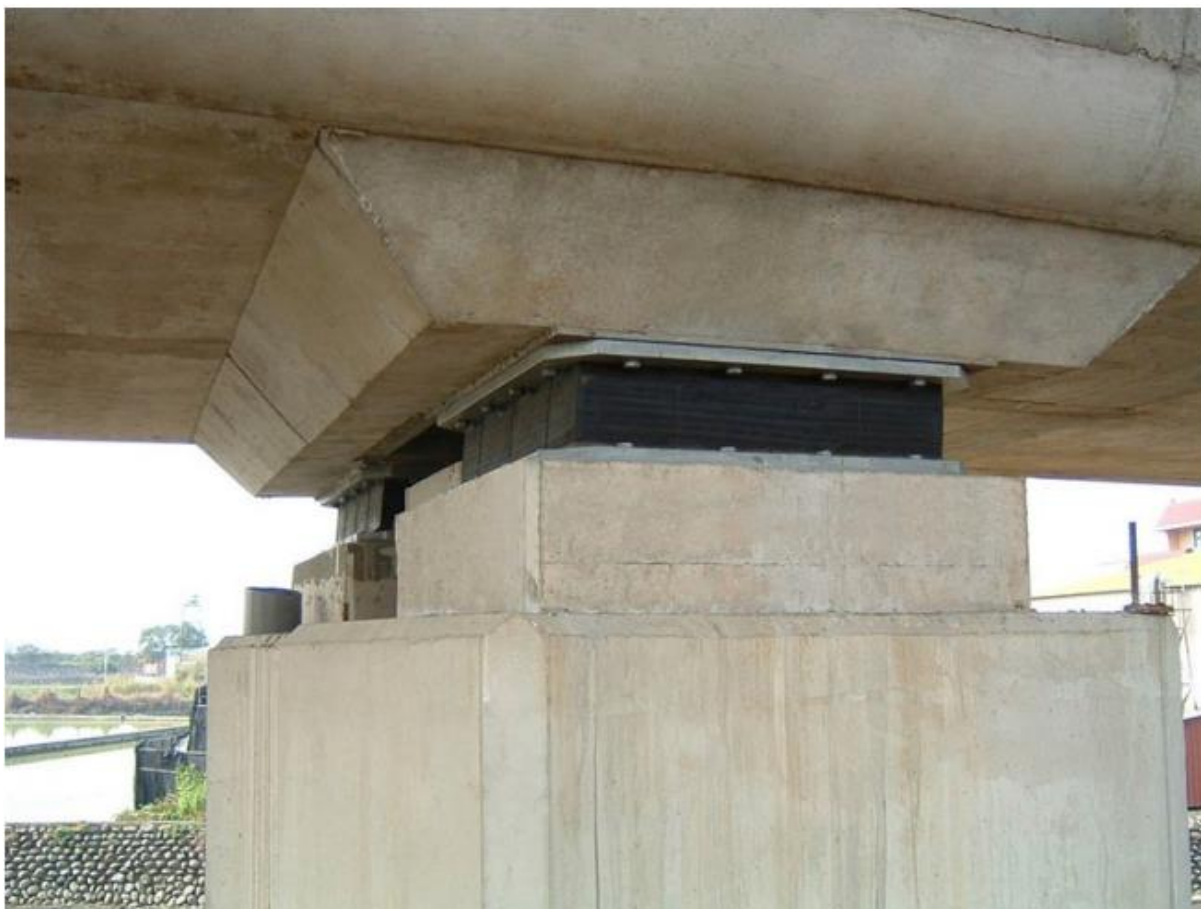
Figura 44: Aparelho de apoio em ponte.
