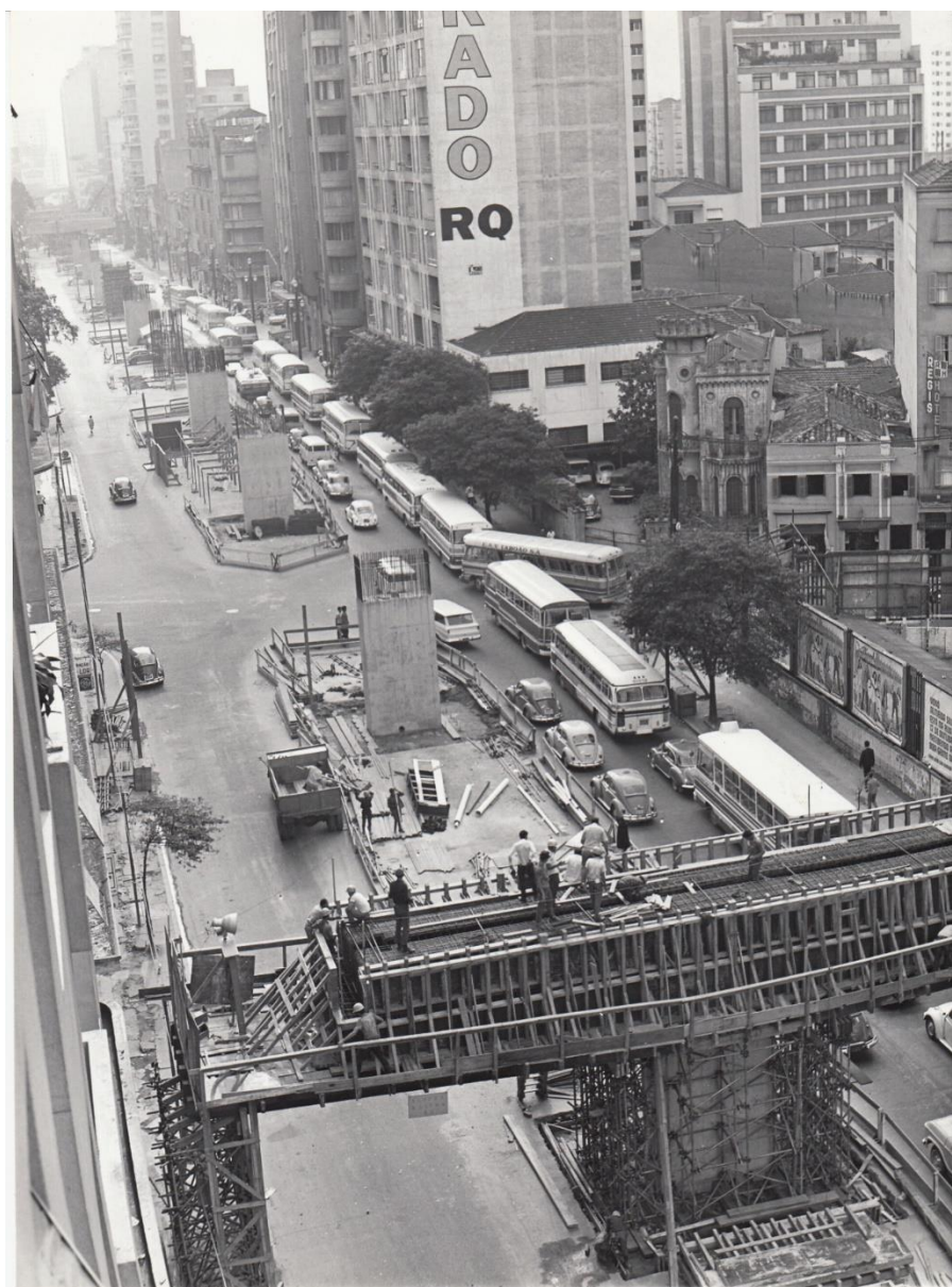
Figura 47: Etapa de cimbramento das vigas.
