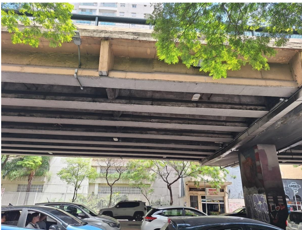
Figura 70: Tabuleiro com oito longarinas.
