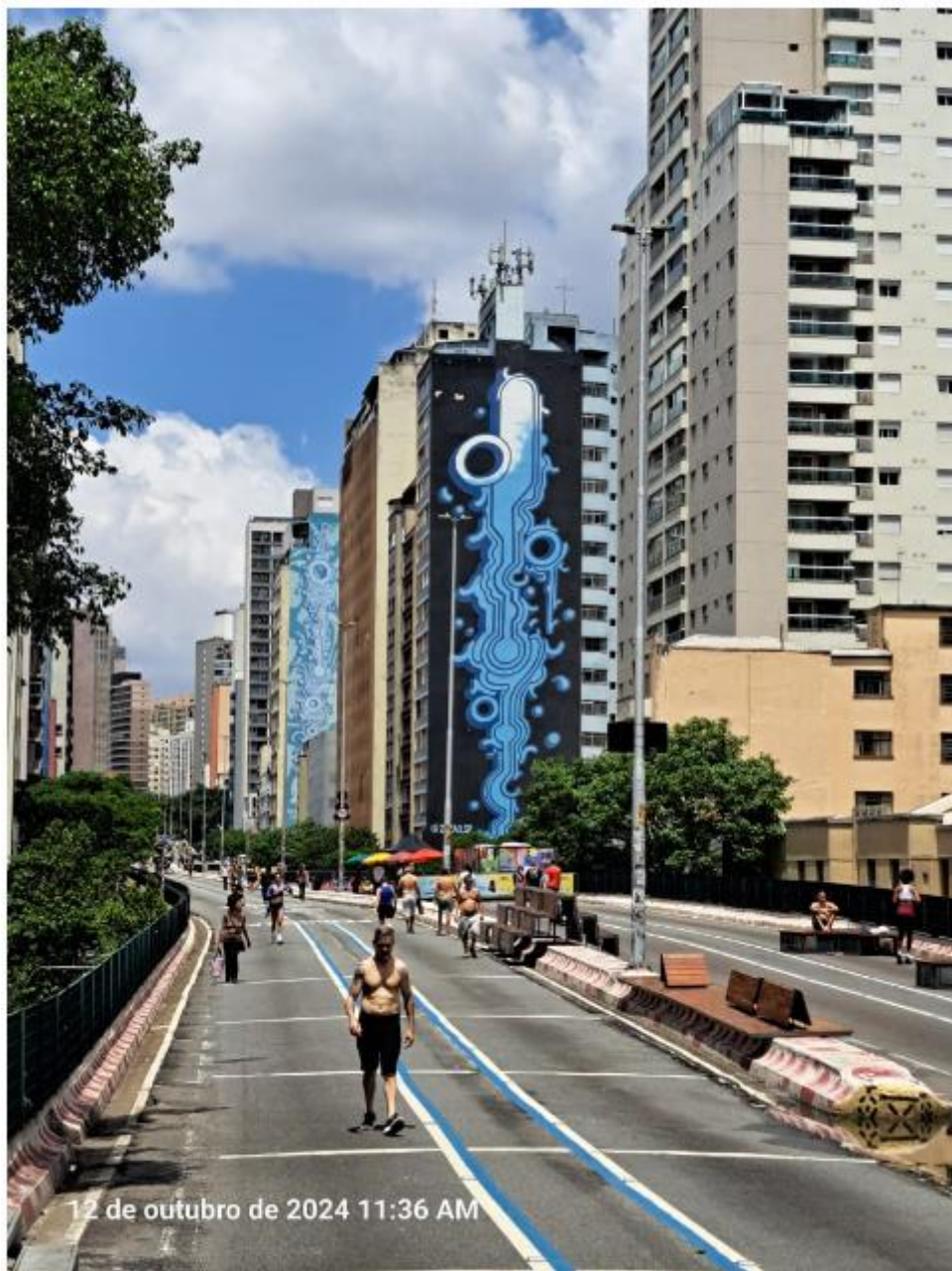
Figura 45: Imagem parte superior da via elevada.
