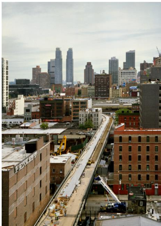
Figura 85: High Line Park sendo construído.
