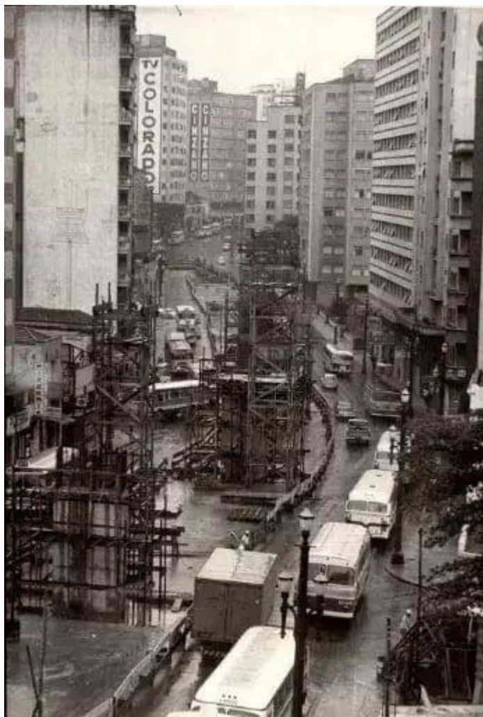
Figura 46: Etapa execução das formas dos pilares.
